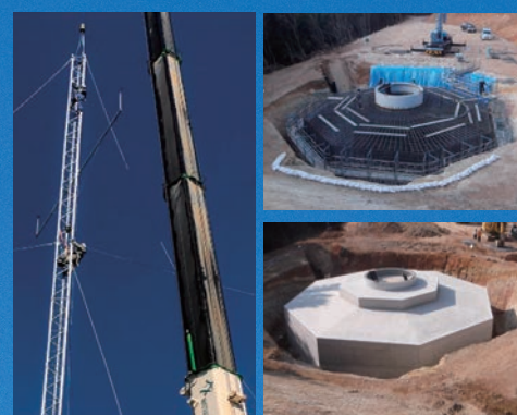
●60m 計測タワーの設置 ●基礎の設計
